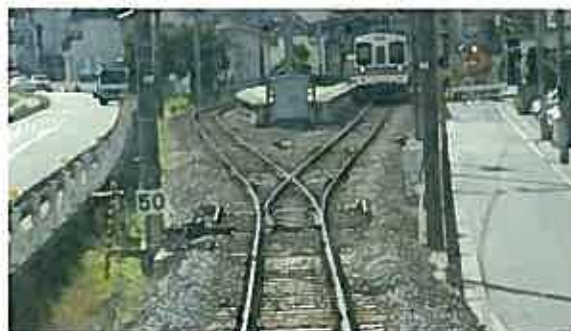
図-47 行き違い設備の例（三滝駅）
